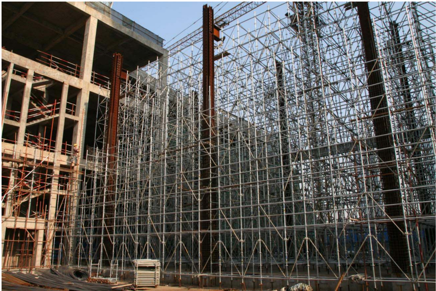
江苏交通银行18m高支模采用盘扣式钢管支架
