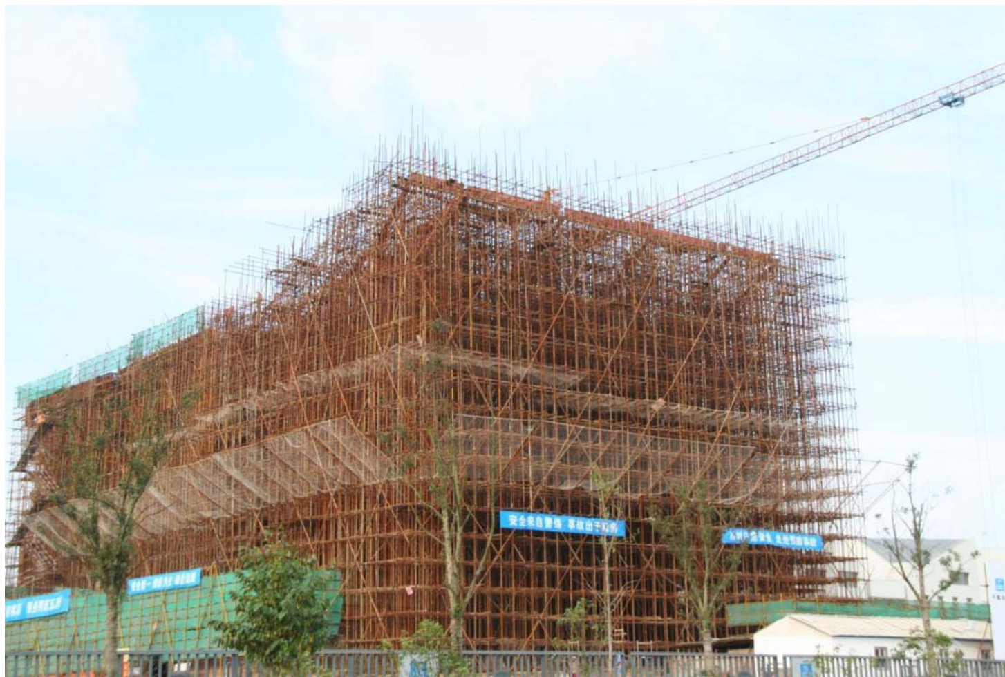
满堂支撑架浇筑楼板混凝土
