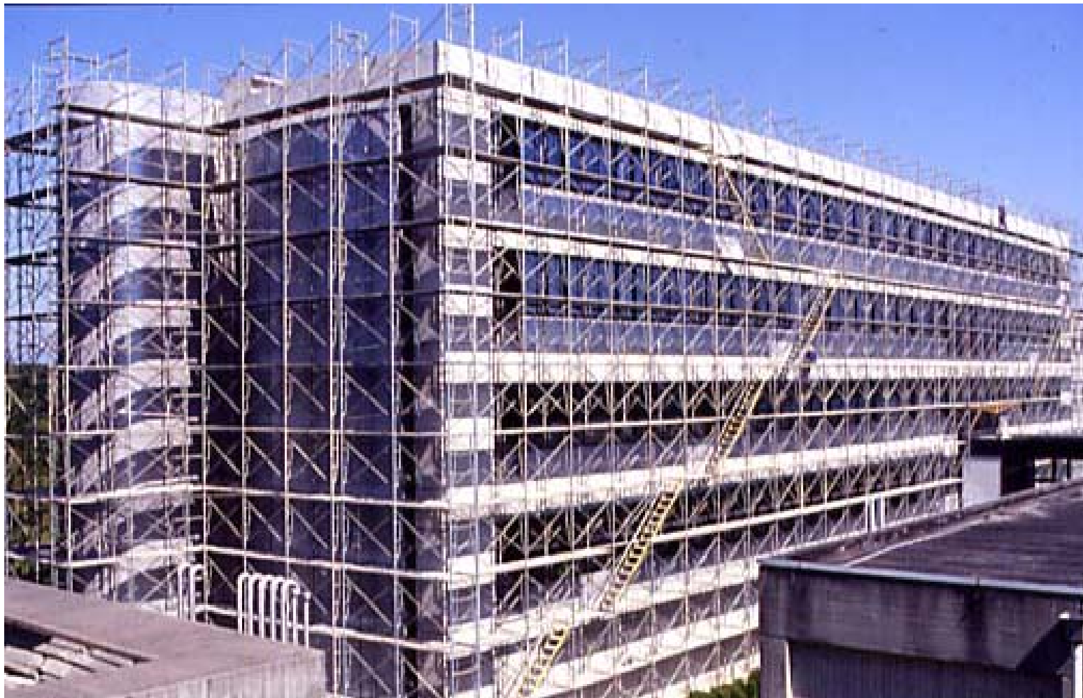
日本爱知工业大学教学楼外墙改造装饰施工采用门式脚手架作为施工外脚手架。
