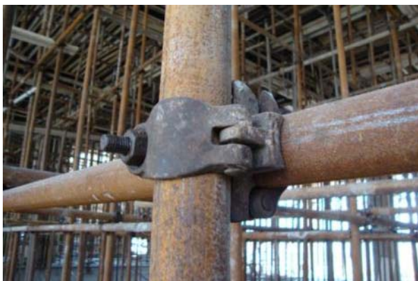
扣件式钢管支架节点
