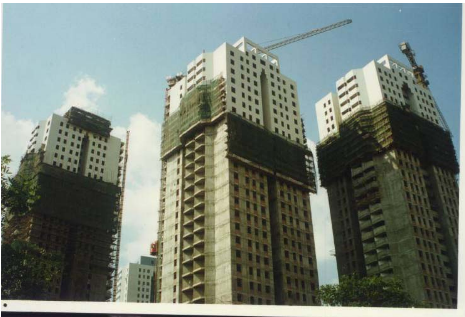
南京估衣廊30高层住宅应用情况
