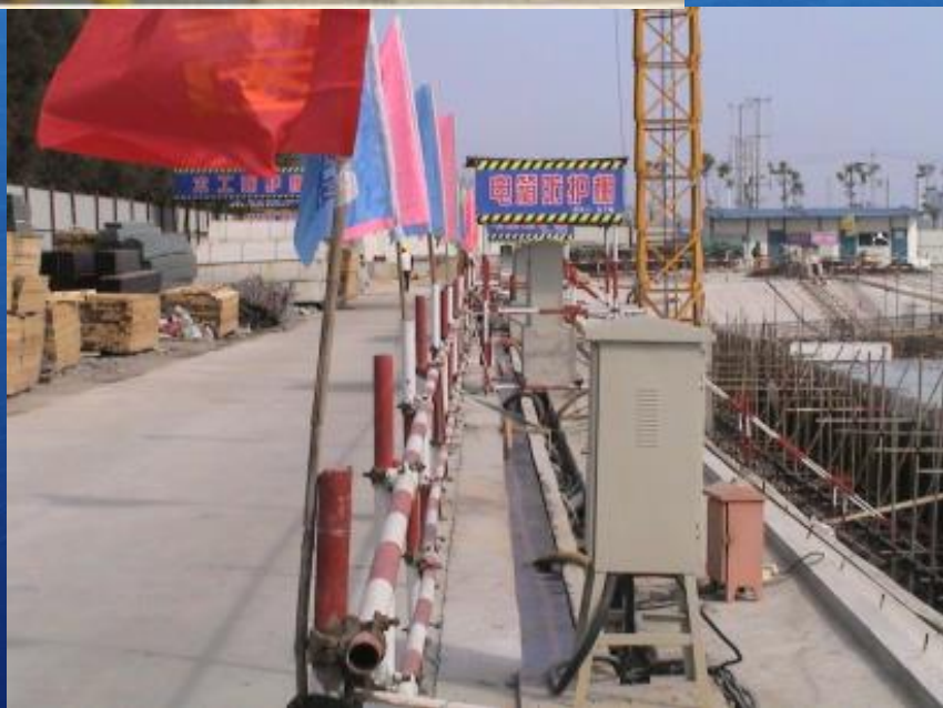
主干道及脚手架排水沟
