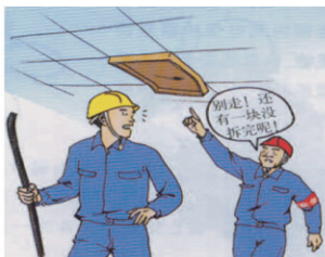
(5) 拆模时不得留有悬空的模板，以防落下砸伤人。
