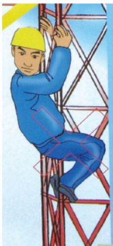
(6) 物料提升机作业时，严禁攀爬架体。
