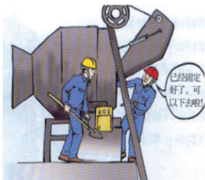
(3) 搅拌机当料斗升起时，严禁任何人在料斗下方停留或通行，当需要维修时，应将料斗提升后，用双保险钩或保险插销锁住方可进行。
