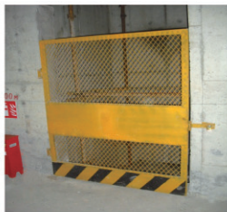
(2) 电梯井口防护措施
