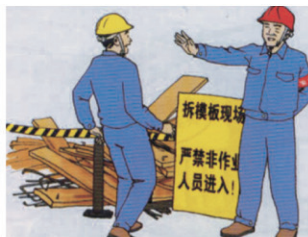
(6) 拆模现场要有专人监护，禁止无关人员进入拆模现场。
