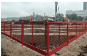
(1) 基坑周边防护
