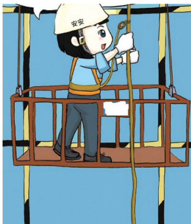
(7) 高处作业吊篮作业，请系好安全带，吊篮内最多只能上两人。
